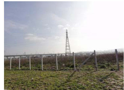
電路鐵塔現況
