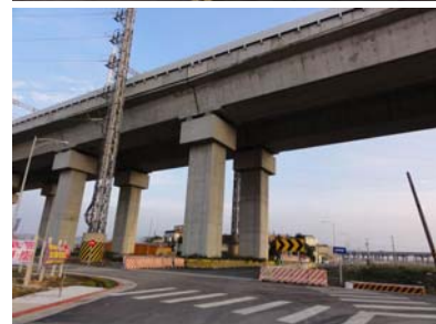
高鐵路橋下空間
